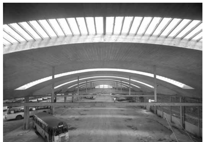
Rouen, rue de Constantine, le nouveau garage des autobus. Vues de l'extérieur (à gauche) et de l'intérieur du garage (à droite)
